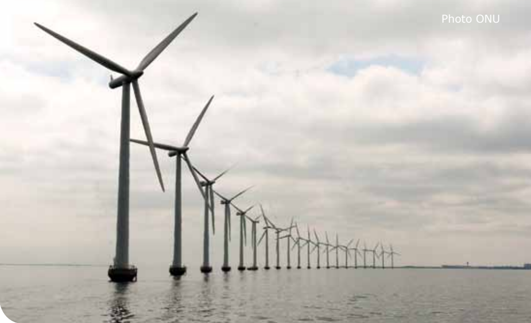
Le parc d'éoliennes en mer de Middelgruden, au Danemark
